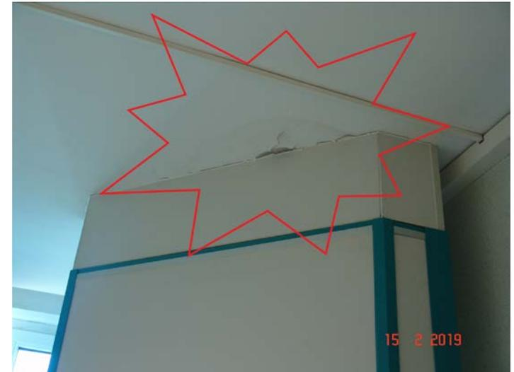
Bild) und einem Chemie - Klassenraum (rechtes Bild). Hinter der senkrechten Wandverkleidung aus Gipskarton (li.) befinden sich Fensteröffnungen, welche verkleidet wurden. Schadstellen im Dachaufbau verursachen wiederkehrende Schäden in den Innenräumen.
