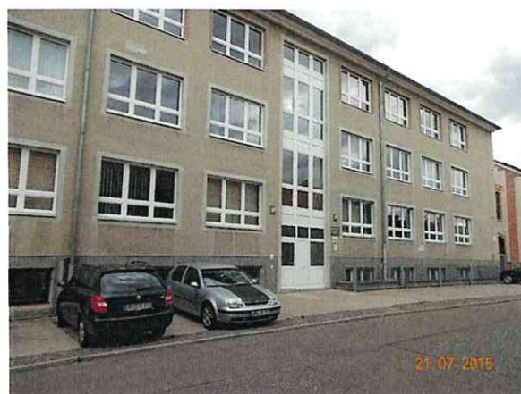
Süd-West-Seite (Eingangsbereich Straße)
