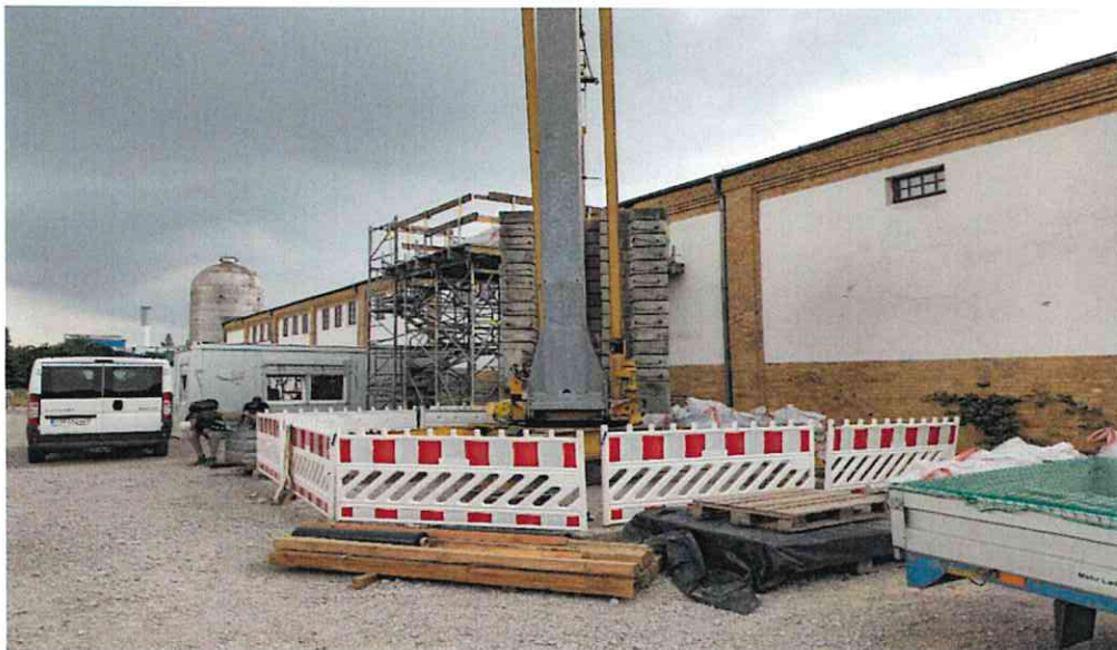
rückwärtige Andienung der Baustelle
