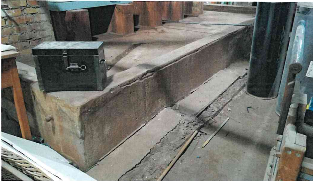
Abbruch Hohlmauerwerk des Podestes, darin Dämmung und Dachpappe zur Entsorgung
