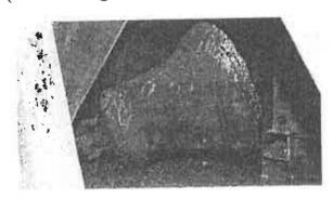
Diese Glocke hat eine Größe (Höhe 65 cm, Durchmessen 66 cm, Gewicht ca. 175 kg) und kann nur mit großen manuellen Aufwand und unter zu Hilfenahme von Feuerwehrtechnik (Mechanische Leiter und Krantechnik) über die obere Fensteröffnung aus etwa 20 m Höhe geborgen werden.
