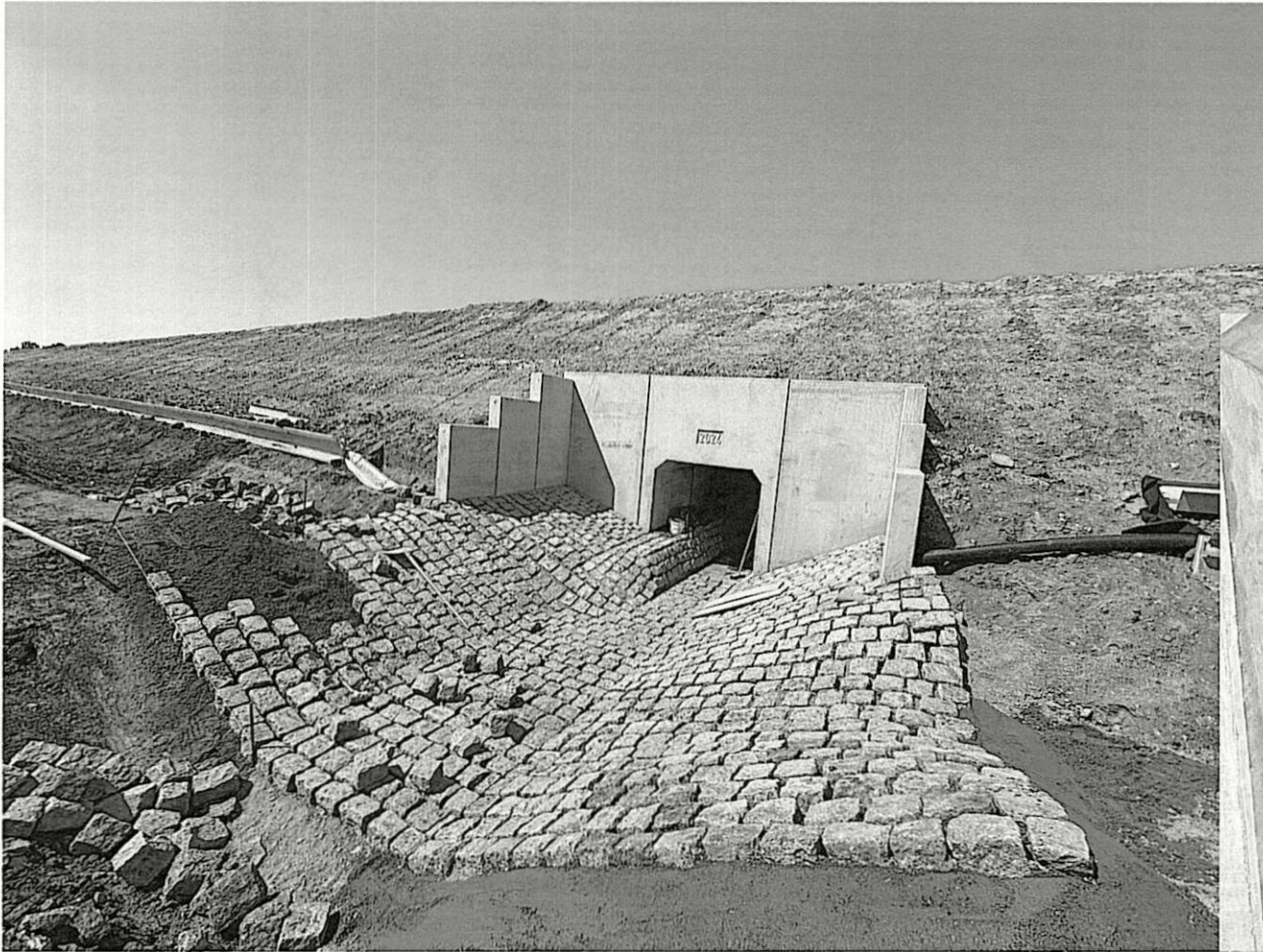
BW Pfriemsdorfer Graben mit Otterberme K 2079
