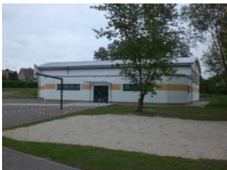
Bild 3: Blick über Kleinsportanlage auf neue Turnhalle
